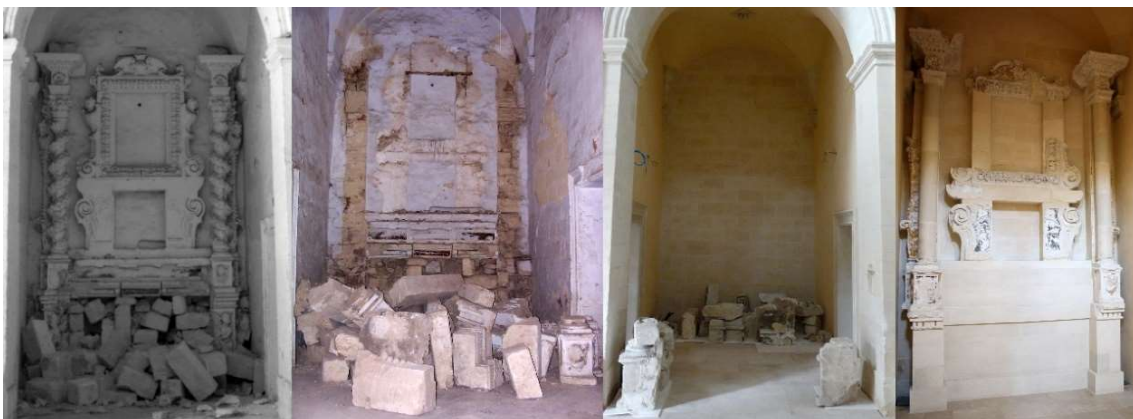
Figura 1. Chiesa di S. Maria di Ognibene, Lecce. La seconda cappella di sinistra in un'immagine d'epoca (Paone 1979), nel 2007, nel 2011 e nel 2016 a conclusione dei lavori.
