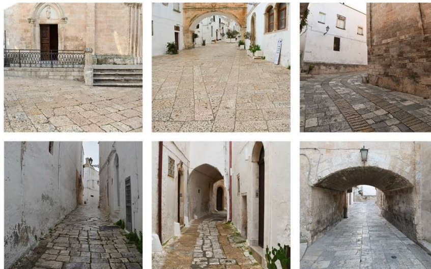
Figura 5. Viste delle diverse tipologie di pavimentazione presenti nell'area di studio.
