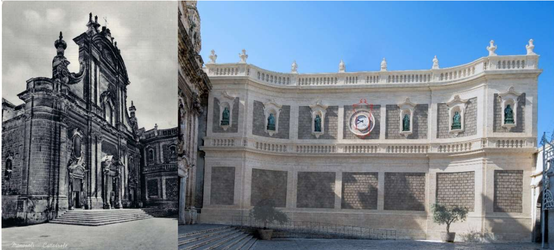
Figura 2. Monopoli, Muraglione. Nell'immagine d'epoca si individua la differenza di trattamento delle superfici modanate e delle lesene rispetto ai fondi a bugnato. La ricostruzione grafica reinterpreta una fase storica dell'architettura e degli apparati scultorei sulla base di quanto emerso in fase di restauro. Al centro, in corrispondenza dell'orologio, è stata rinvenuta la sagoma di un'altra nicchia, chiusa probabilmente contestualmente all'installazione dello stesso. Al periodo di inserimento del meccanismo potrebbe risalire la realizzazione del campanile a vela, dalle forme e stilemi neoclassici, che non era parte della originaria configurazione.
