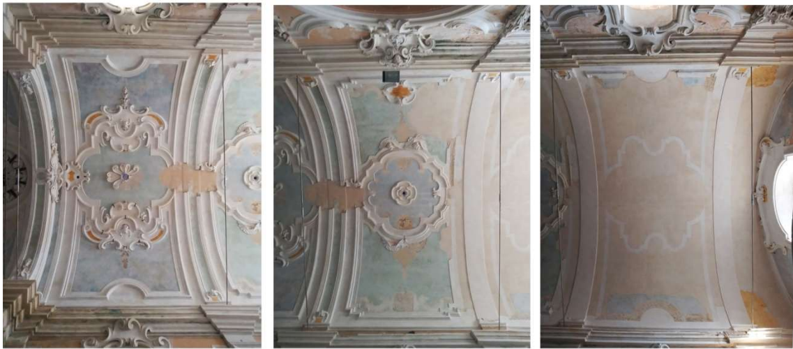
Figura 4. Trattamento delle lacune nelle tre campate della volta dell'aula.
