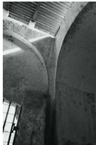
Figura 4. Chiesa Lama d'Antico, Fasano: cupola navata centrale (foto dell'autrice).
