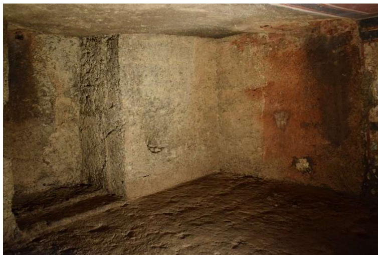
Figura 5. Banco roccioso camera funeraria “ dopo l'applicazione degli oli essenziali in soluzione a pennello.
