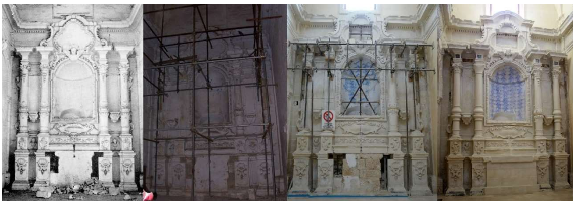
Figura 4. Chiesa di S. Maria di Ognibene, Lecce. L'altare del transetto destro in un'immagine d'epoca (Paone 1979), nel 2007, nel 2011 e nel 2017 a conclusione dei lavori.
