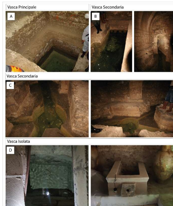
Figura 4. Foto delle vasche di adduzione. Per la loro ubicazione si veda la figura 3. A) Vasca principale, al di sotto del piazzale del Santuario Mater Domini. B) e C) Vasche secondarie poste in destra idrografica rispetto al condotto principale. D) Vasca di capitazione isolata presente in una cantina in prossimità della Fontana dei Mascheroni.
