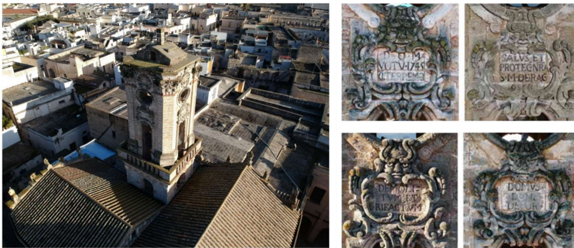
Figura 5. Particolare dei mascheroni apotropaici (a destra) collocati nel 1745 sui quattro lati del campanile della Chiesa di Santa Maria de Raccomandatis (a sinistra) a ricordo e voto del terremoto del 1743.
